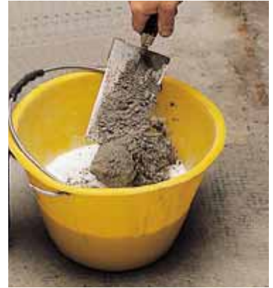
Préparation de la barbotine d'accrochage composée de Mapecem et Planicrete
