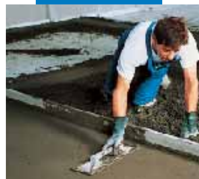
Finition par talochage du mélange Mapecem
