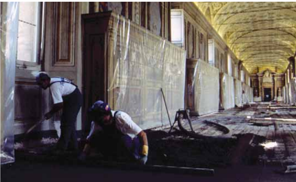
Application et finition de la chape Mapecem - Salons Sixtines - Cité du Vatican
