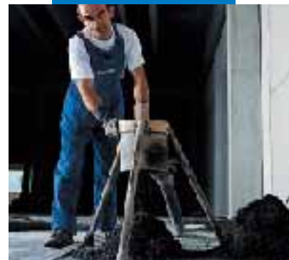
Alimentation du mélange Mapecem
